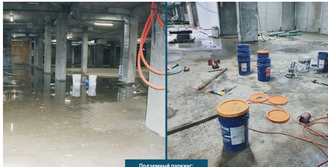
Подземный паркинг: до и после завершения работ
