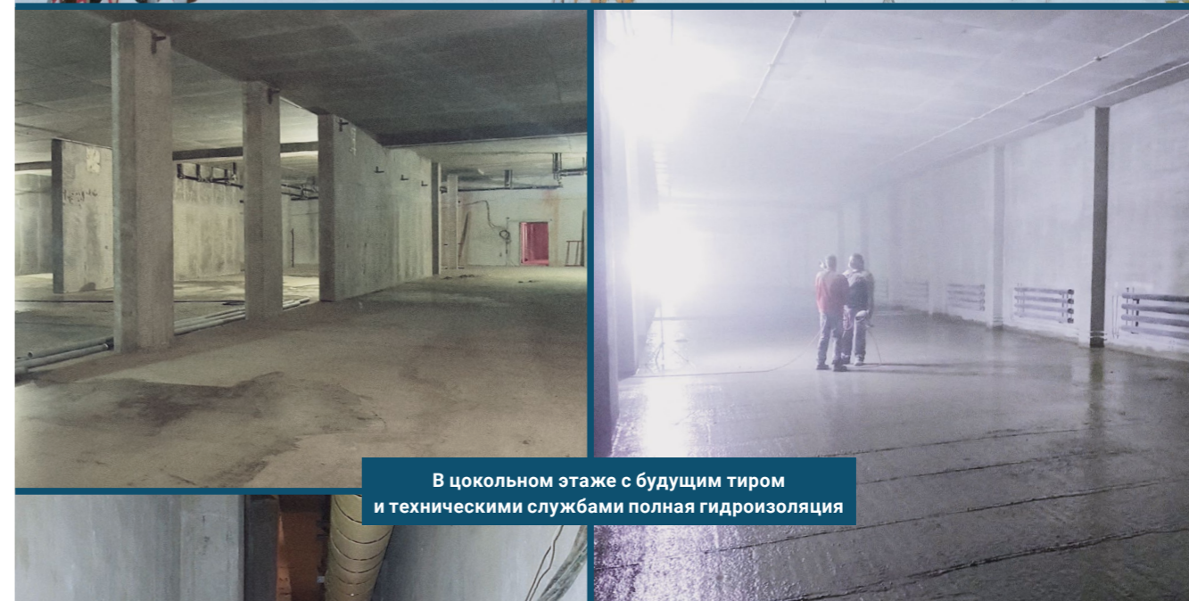
Спорткомплекс «Динамо» в завершающей стадии строительства
